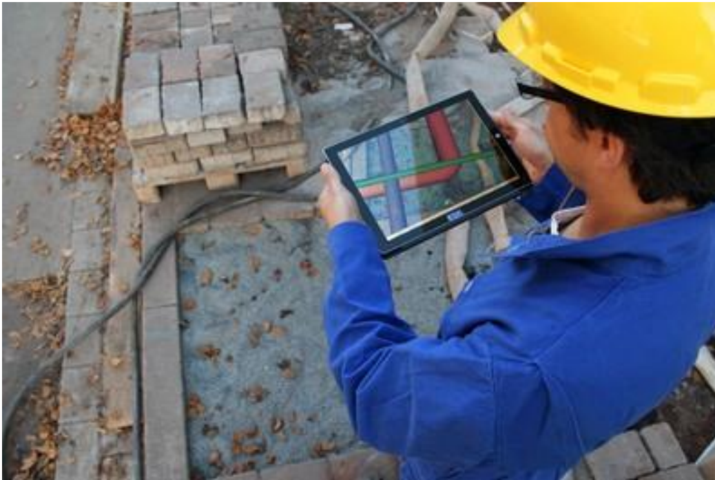
LARA: Der Röntgenblick für den Tiefbau – Augmented Reality-Unterstützung für Aushubarbeiten [Quelle: DFKI]
